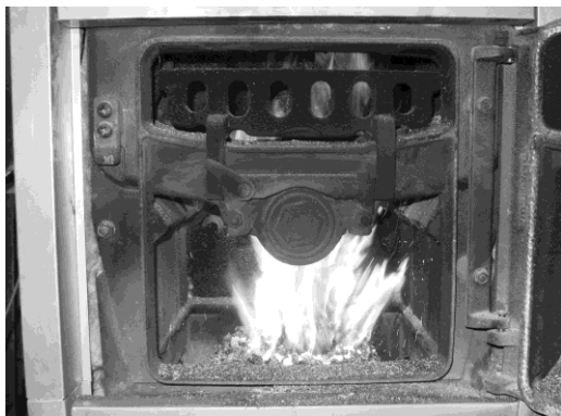
Obr. č. 37 Optimální tvar plamene
