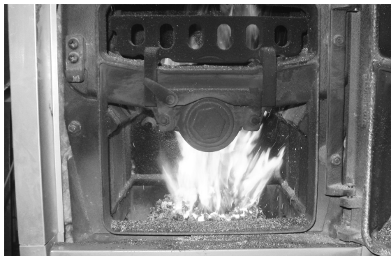
Obr. č. 31 Optimální tvar plamene
